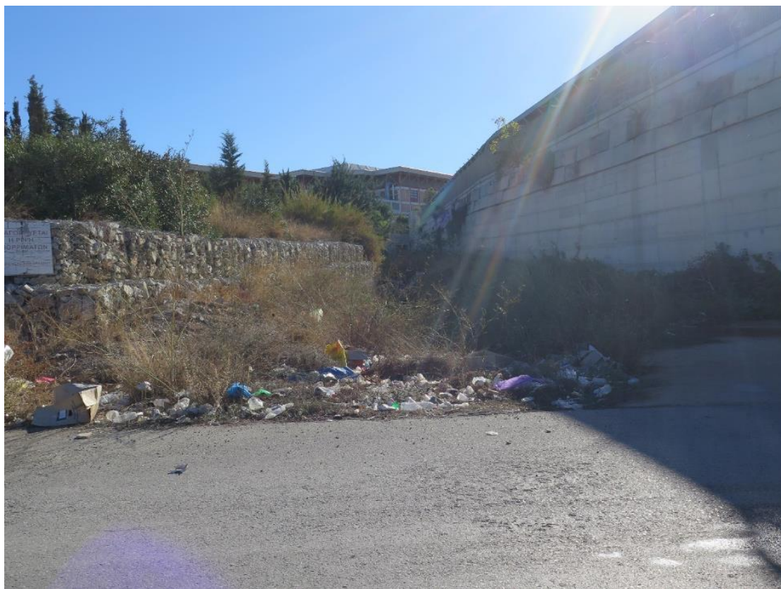
Φωτογραφία 11: Συρματοκιβώτια οριοθέτησης στο νότιο τμήμα του αποκατεστημένου ΧΑΔΑ στα όρια του εκεί αναπτυσσόμενου ρέματος
