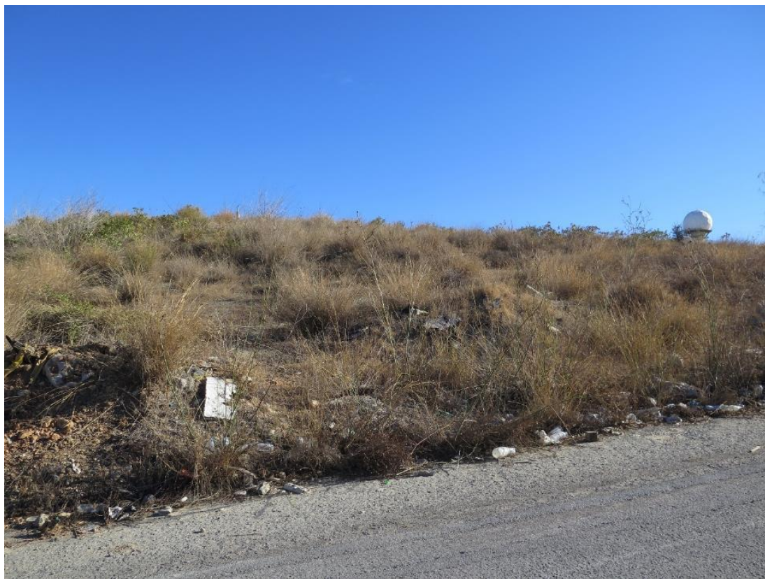
Φωτογραφία 10: Επιφάνεια αποκατεστημένου ΧΑΔΑ
