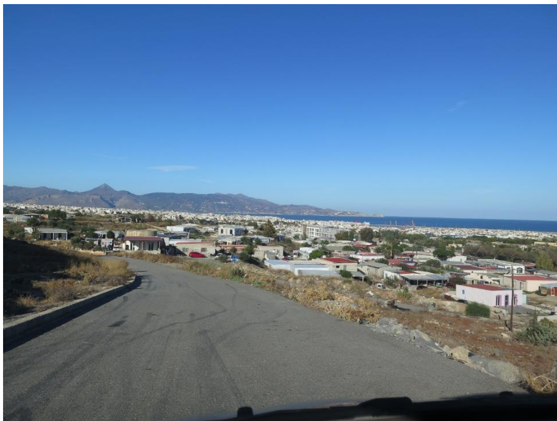
Φωτογραφία 3: Γενική άποψη του καταυλισμού των Ρομά. Αριστερά διακρίνεται ο αποκατεστημένος ΧΑΔΑ
