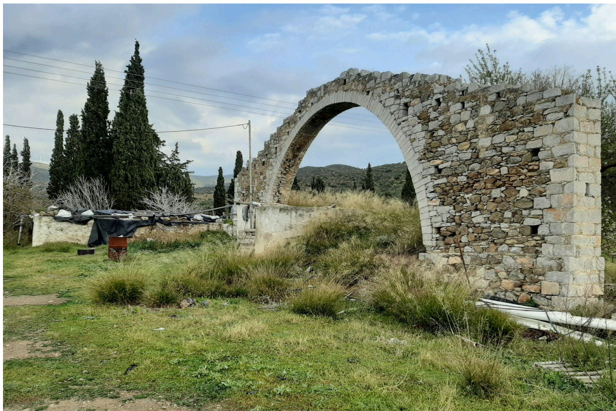
Εικόνα 4: Άποψη τοξωτής κατασκευής, τμήματος παλαιού λιθόκτιστου υδραγωγείου
