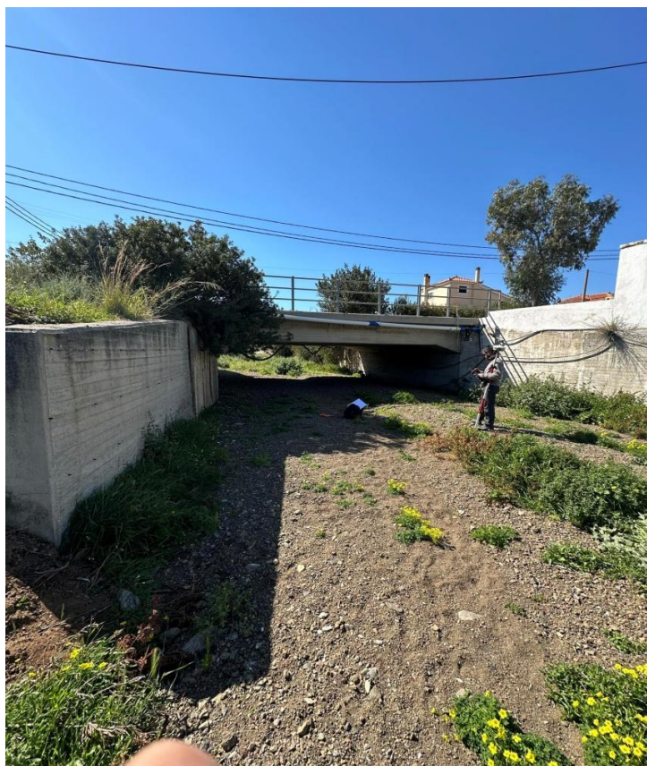
Φωτ. 6 : Κοίτη ρέματος «Πλέπι» στην θέση της Γέφυρας της Ε.Ο. Ερμιόνης-Γαλατά .
