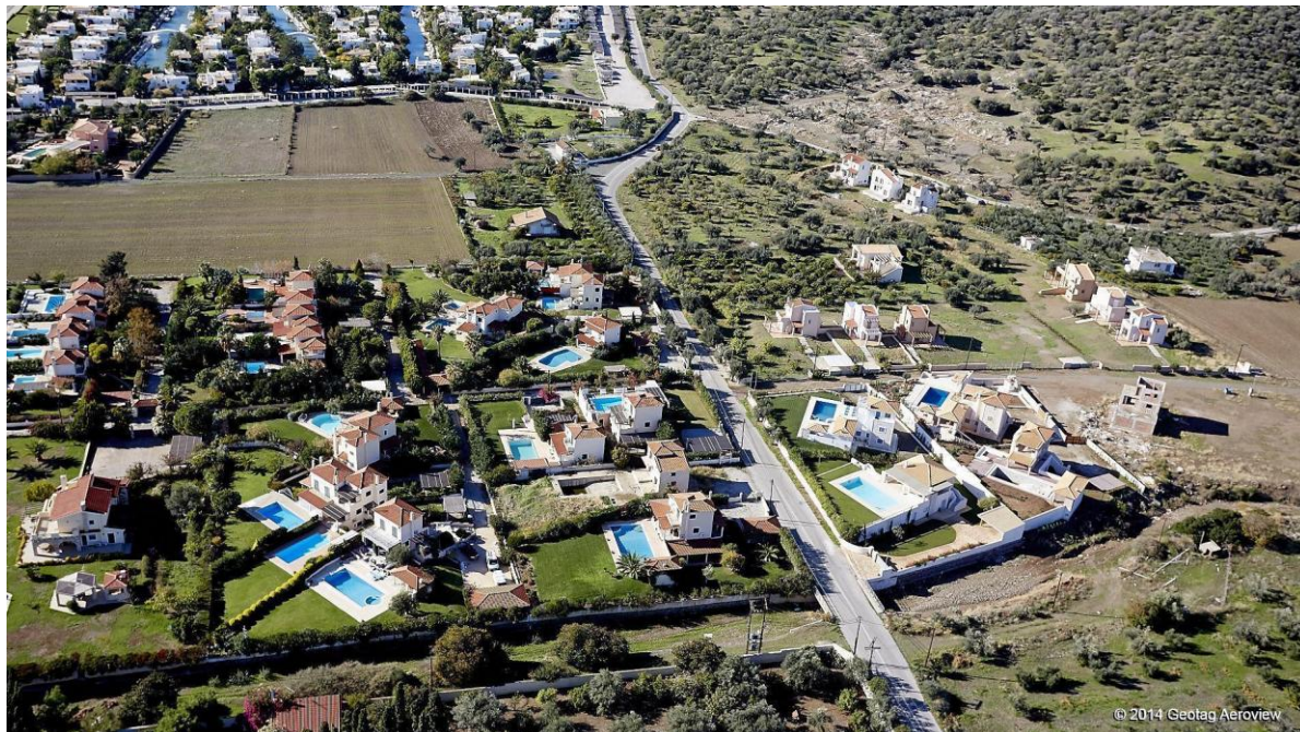
Φωτ. 5 : Κοίτη ρέματος «Πλέπι» στην περιοχή της Γέφυρας της Ε.Ο. Ερμιόνης-Γαλατά. Διακρίνονται εκατέρωθεν της κοίτης μάντρες παρόχθιων ιδιοκτησιών.
